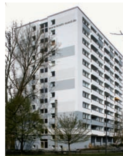
Hochhaus Luxemburger Straße nach der Modernisierung Foto: © LUWOGÉ consult
